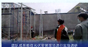
团队成员前往光伏安装现场进行实地调研
