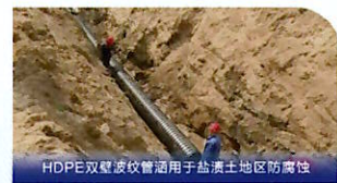
HDPE 双壁波纹管涵用于盐渍土地区防腐性
