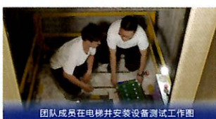
团队成员在电梯井安装设备测试工作图
