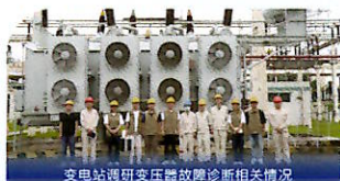
变电站调研变压器故障诊断相关情况
