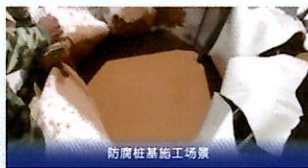
防腐桩基础施工现场
