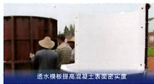
透水模板提高混凝土表面密实度
